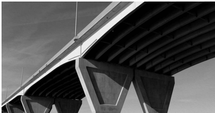
Figure 7 : ouvrage mixte pour lequel un grand nombre de poutres de faibles dimensions ont été mises en place, photo de Christophers Sessums
