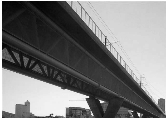
Figure 6 : la poutre métallique n'est pas nécessairement un profilé mais peut-être, comme ici, une poutre treillis, photo de Alan Levine
